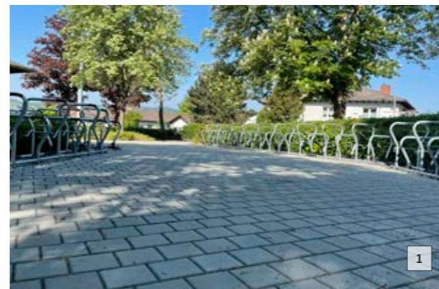
Das harmonische Pflasterbild fügt sich in jedes Umfeld ein. Die Versickerungsleistung des Systems ist bei geeignetem Unterbau in der Lage, auch starke Regenspender zu bewältigen. Die angeformten Noppen ermöglichen zwei verschiedene Verlegearten.
